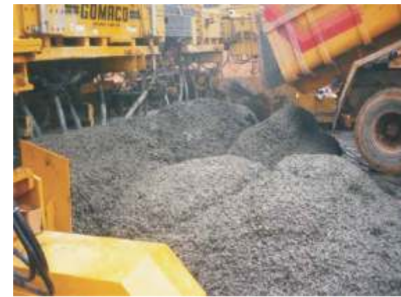
Figura 13 – Transporte y descarga de concreto en camiones basculantes (volquetes)
