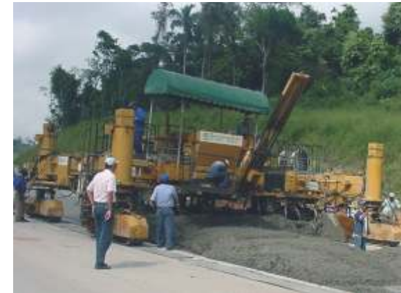
Figura 14 – Distribución del concreto por el tornillo sin fin de la pavimentadora
