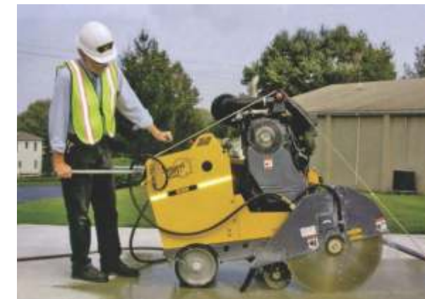
Figuras 19 – Corte de las juntas
