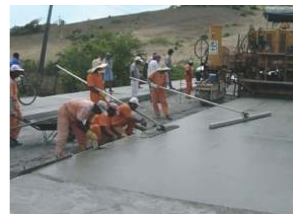
Figura 16 – Acabado del concreto
