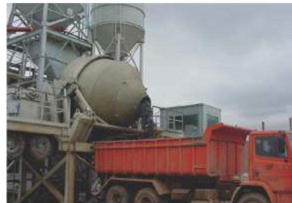
Figura 12 – Producción de concreto (planta dosificadora y premezcladora)
