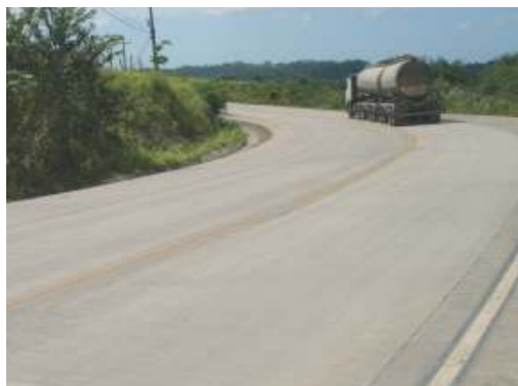
Figura 31 - Carretera SE-432 - Aracaju/SE
