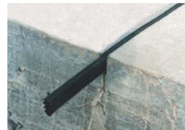
Figuras 20 – Sellado de las juntas
