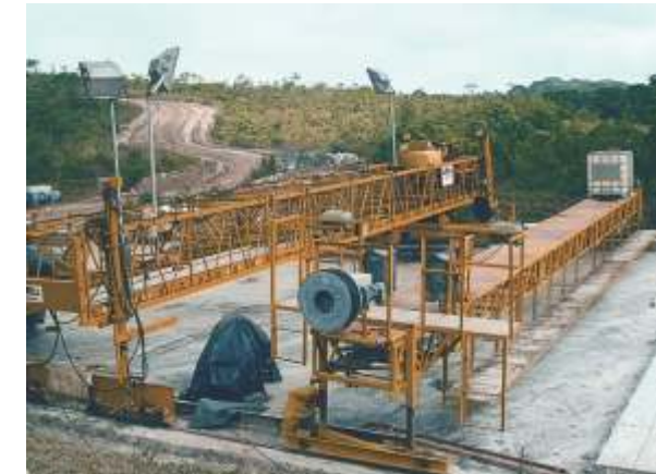
Figura 7 – BID-WELL - acabadora operando sobre formas fijas
