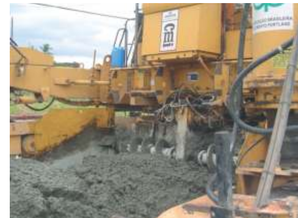
Figura 15 – La compactación del concreto se realiza con la ayuda de vibradores de inmersión
