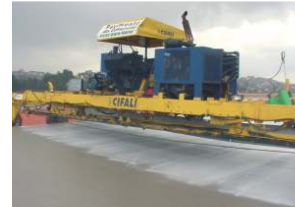
Figura 18 – Curado químico mecanizado
