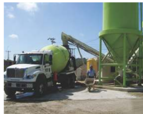
Figura 5 – Planta móvil de concreto dosificadora
