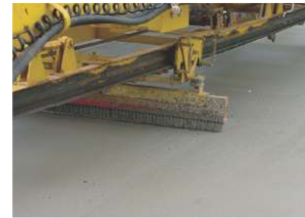
Figura 17 – Texturizado del concreto
